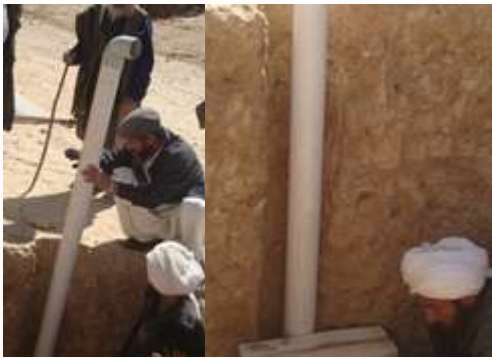
شکل 9، نصب پایپ هواکش. منبع: سی آر اس 2013
